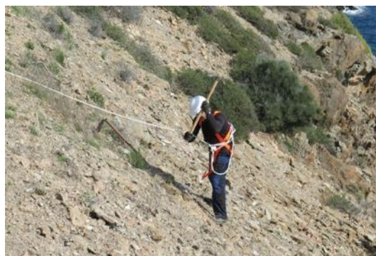
Tareas de ahoyado en La Chapa y Cenizas
