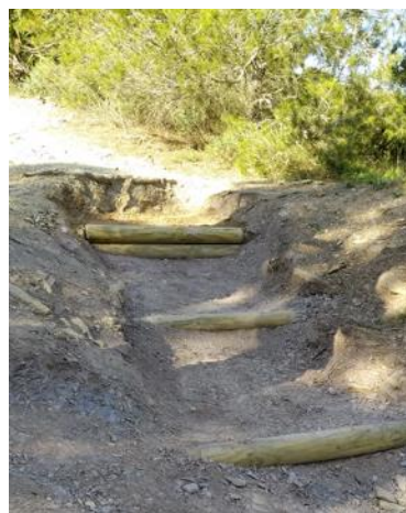
Escalones de madera para evitar erosión en zonas de alta pendiente
