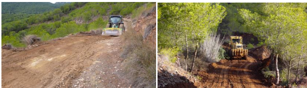
Obras de arreglo de caminos. Acción C5
